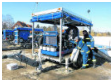
Wartungsarbeiten am Pumpenaggregat
